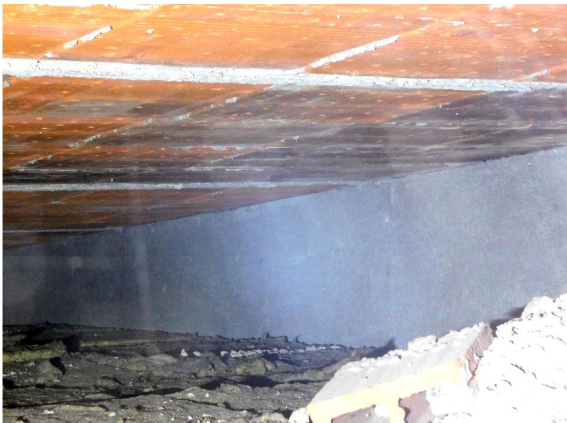
Foto 3 – pohled do dutiny střechy – dole patrná izolační vata, vpravo středové příčné žebro pro uložení střechy (vyznačeno modře na Foto 1), nahoře patrné keramické vložky a betonová skrytá žebra
