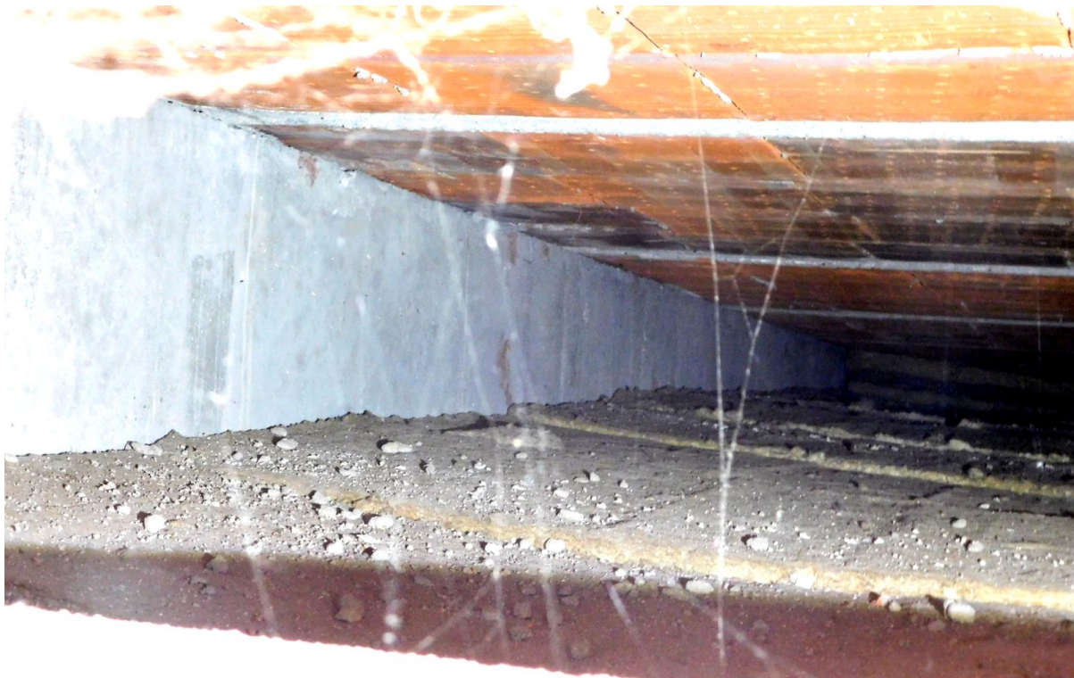
Foto 2 – pohled do dutiny střechy – dole patrná izolační vata, vlevo obvodová římsa (západní štít), nahoře patrné keramické vložky a betonová skrytá žebra
