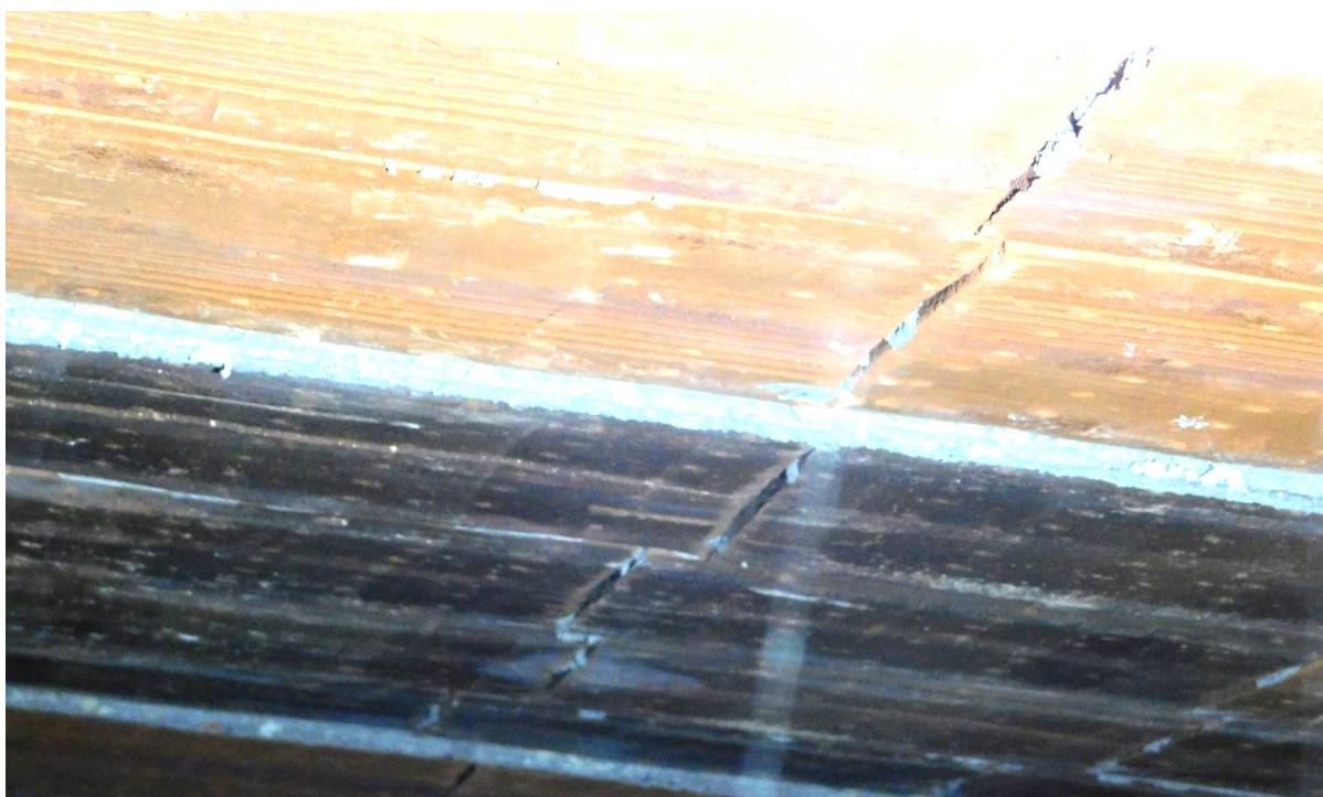
Foto 4 – pohled do dutiny střechy – patrné keramické vložky a betonová skrytá žebra
